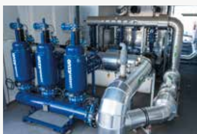
3x AZUD LUXON LDB 5400 S/8 Circuito de refrigeración de máquina inyectora
